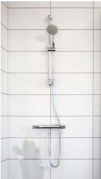
Standard Grohe Nordic termostat- batteri og Grohe New Tempesta dusjgarnityr. NRF nr: 4220773 + 4221492
