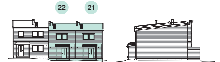
Hus 2 – fasade mot sør-øst
